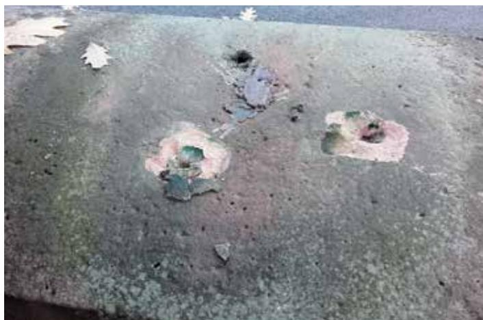
Beschädigte Mauer: mit großer Kraftanstrengung wurde die Schale herausgerissen.
